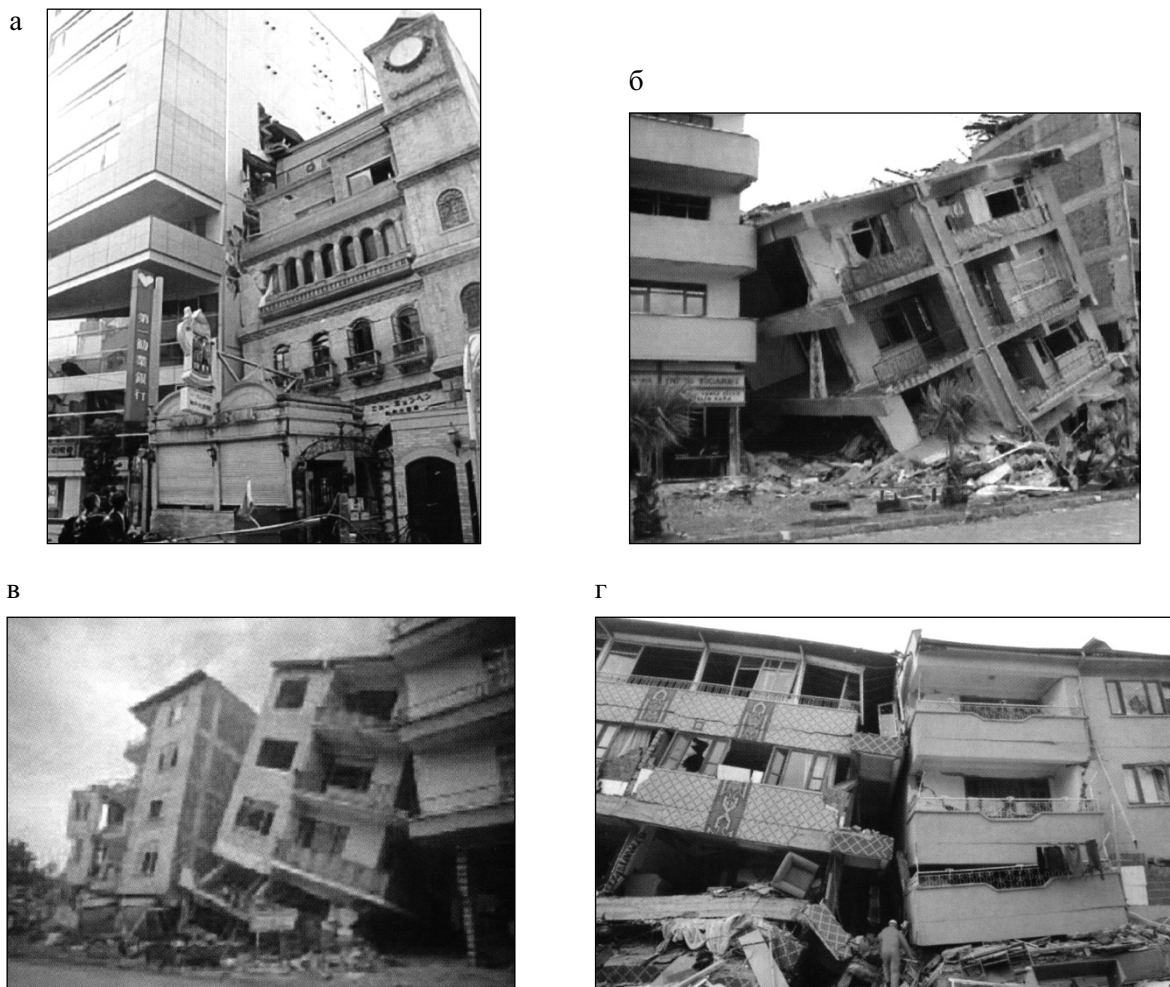
Рис. 1. Примеры разрушений зданий разных конструктивных схем: а) Кобе (Япония, 1995 г.); б) жилой дом с первым «гибким» этажом в Измите (Турция, 1999 г.); в) жилой дом в Измите (Турция, 1999 г.); г) соударение 4-этажных зданий (Турция, провинция Ван, 2011 г.)
