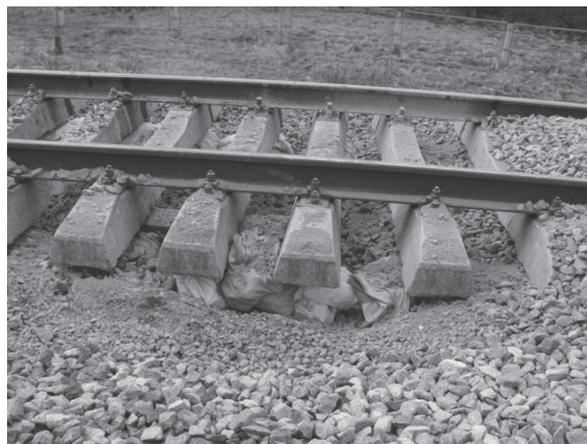
Рис. 2. Применение мешков со щебнем для устройства отвода в месте зарядки машины
