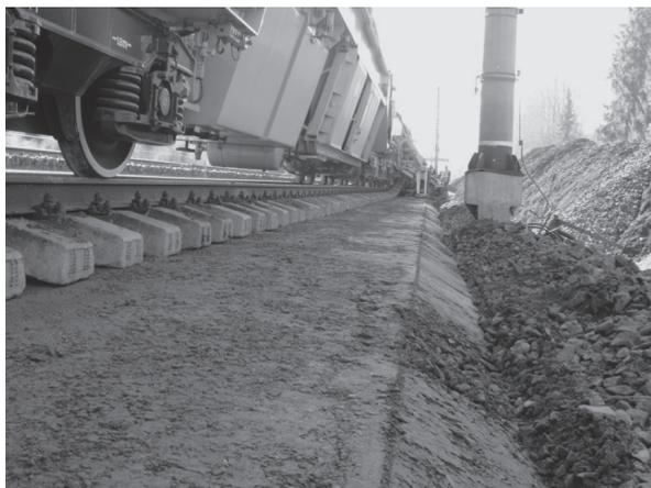
Рис. 1. Расположение рельсошпальной решетки на сформированном защитном слое
