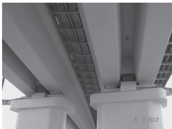
Рис. 5. Стержневые амортизаторы с ФПС на одной из железнодорожных эстакад в г. Сочи
