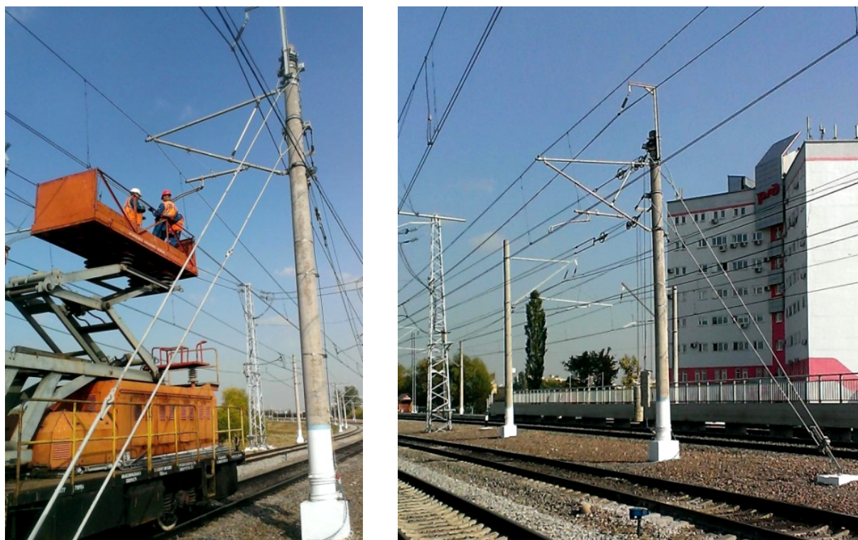
Рис. 8. Опытная эксплуатация композитной консоли
