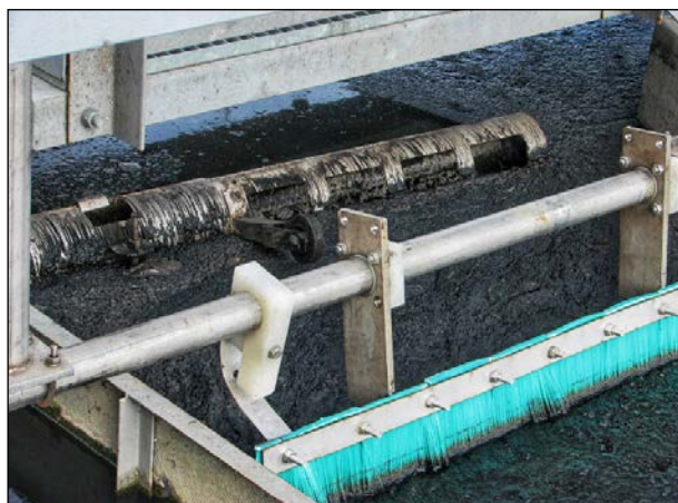
Рис. 1. Система для удаления плавающих загрязнений, пены, корки загнившего ила на радиальных отстойниках КОС г. Петродворца
