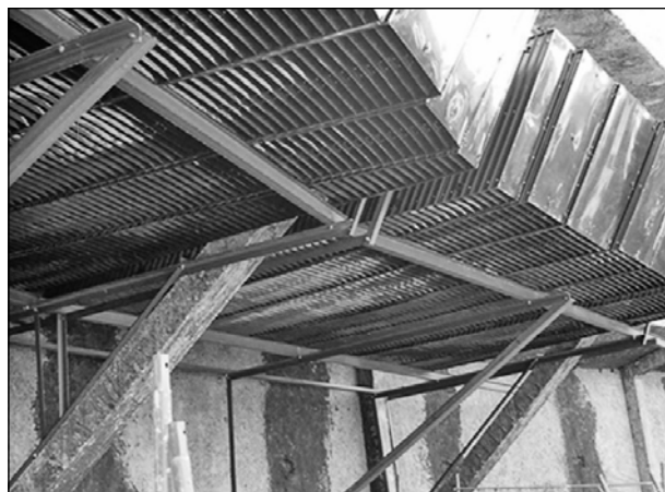
Рис. 3. Реконструкция отстойников КОС С.-Петербурга, полочные блоки с радиальными тонкослойными элементами в процессе монтажа (вид снизу)
