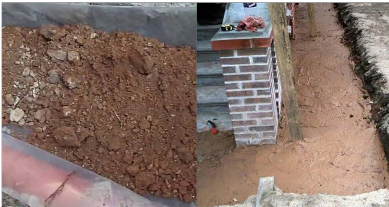
Рис. 2. Устройство глиняного замка с применением бентонитовых глин (источник: https://kalmatron.ru/ )
