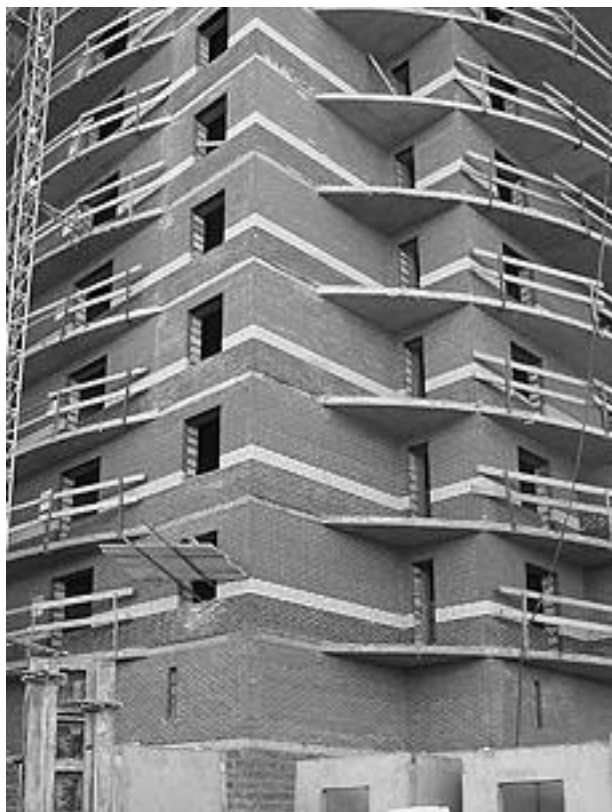
Рис. 1 Возведение жилого здания в г. С.-Петербурге с выпусками плит перекрытий на фасад
