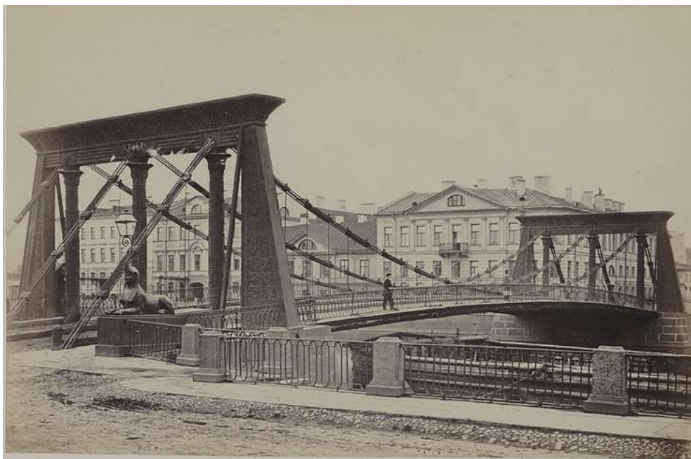
Рис. 1. Египетский мост через реку Фонтанку в Санкт-Петербурге. Металлический однопролетный мост цепной конструкции построен на пересечении Петергофского пр. (Лермонтовский пр.) с рекой Фонтанкой в 1826 г. Проект составлен инженером В. А. Христиановичем при консультации В. фон Треттера. Фото А. Ф. Лоренса, 1860-е гг.
