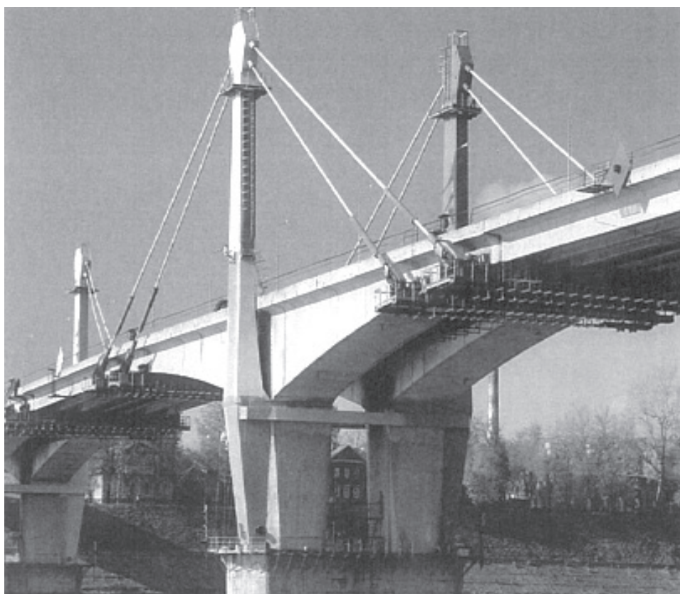
Рис. 5. Мост через реку Волга в г. Кимры после реконструкции (вантовая система)
