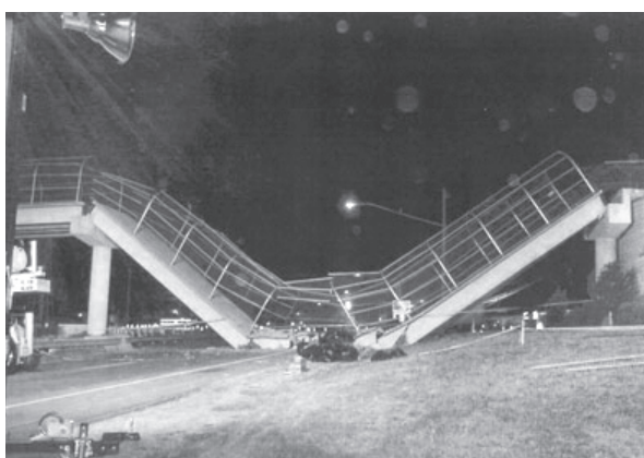
Рис. 1. Обрушение пешеходного моста в городе Шарлотт
