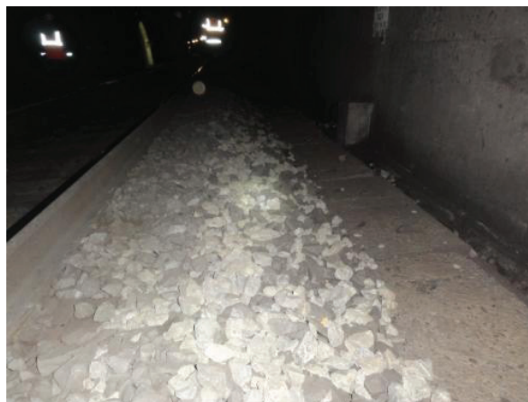
Рис. 11. Плечо балластной призмы с добавлением нового щебня
