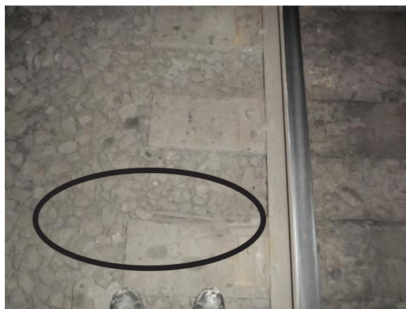
Рис. 9. Дефектные шпалы
