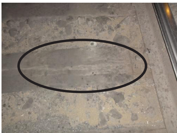
Рис. 9. Дефектные шпалы
