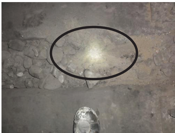
Рис. 10. Мелкие фракции на поверхности балласта в шпальном ящике
