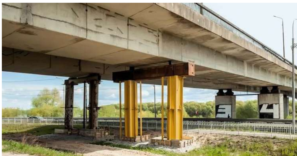
Рис. 1. Капитальный ремонт Колмовского моста в Великом Новгороде. Временная опора (фото МКУ «Управление капитального строительства»)
