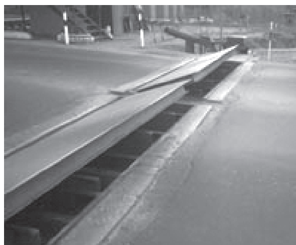
Рис. 5. Устройство заграждения переезда
