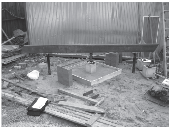
Рис. 2. Общий вид опытной площадки
